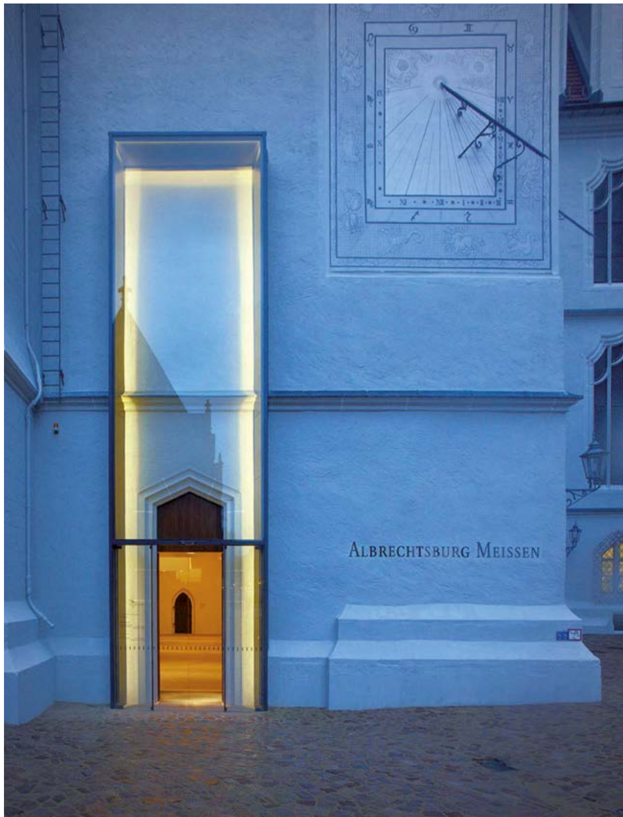
/ Neuer Schlosszugang, Schloss Albrechtsburg Meißen. Die schwellenlose Zugänglichkeit wurde durch eine großflächige Absenkung des Schlosshofes erreicht. Die markante Ausbildung erleichtert die Auffindbarkeit des Eingangs. (Architekturbüro Raum und Bau GmbH)
